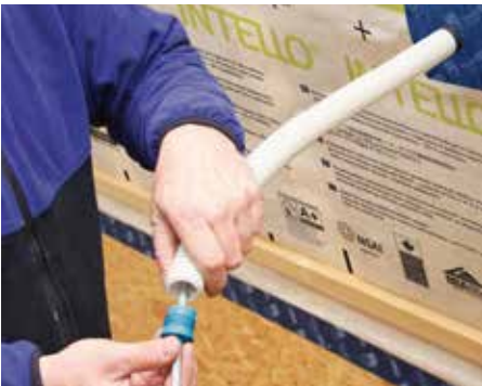
STOPPA hermetizē kabeļus tukšos cauruļvados.
