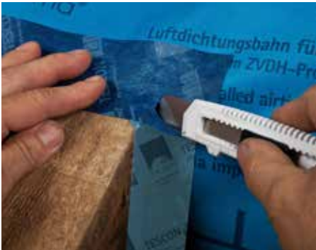
Pielīmējiet membrānu hermētiski pie spārēm ar TESCOFIX VANA.
