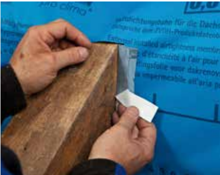
Noņemiet atdalošo plēvi: hermētiski salīmējiet kopā membrānu un spāri.
