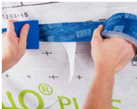
Membrānas pārlaidumu līmēšanai iekštelpās,
