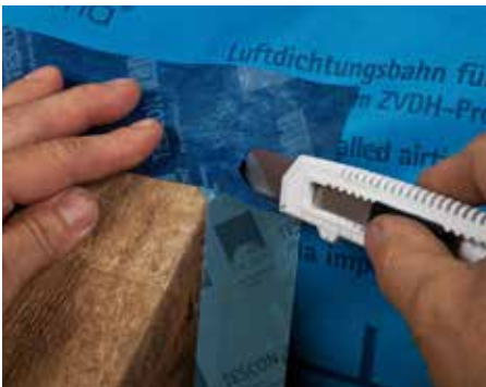
Membraną su TESCOFIX VANA sandariai pritvirtinkite prie gegnių.
