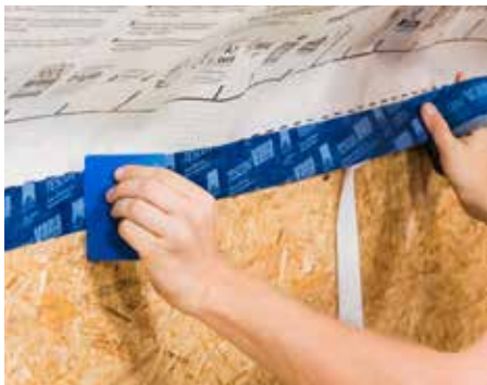
...sujungimai ant medienos drožlių plokščių,
