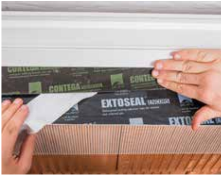
Įdėkite langą, nuimkite apsauginę plėvelę ir priklijuokite aplink visą vidinį paviršių.
