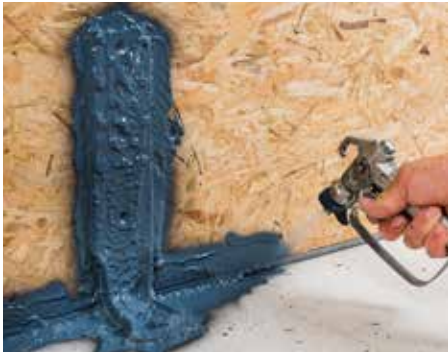
Hermetiškas tvirtinimo kampų apipurškimas,
