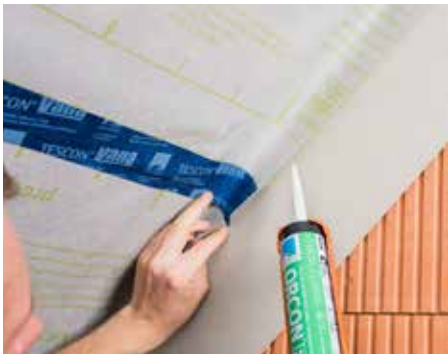
Elastingi klijai vidinėms oro sandarinimo juostoms,
