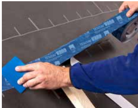
ir išorinių plėvelių persidengimų klijavimas.
