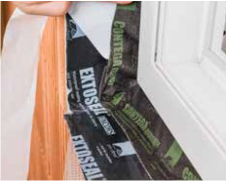
Kampuose klijuoti taip, kad būtų užtikrintas atsparumas orui ir smarkiam lietaui
