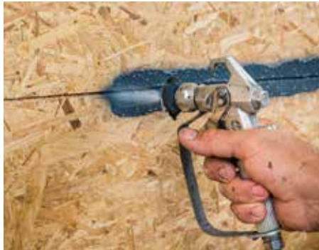
...medienos drožlių plokščių tarpusavio sandūros,
