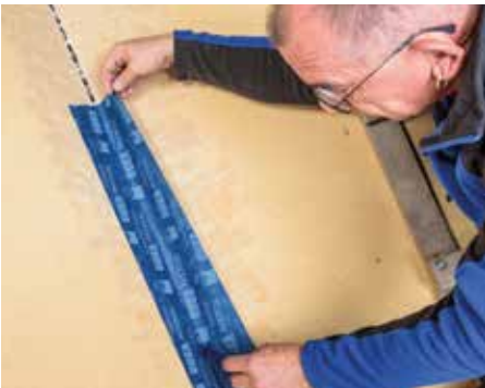
Lipniąją juostą galima klijuoti tiesiai ant šviežio grunto
