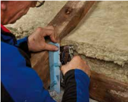
...ir pritvirtinkite prie gegnių.
