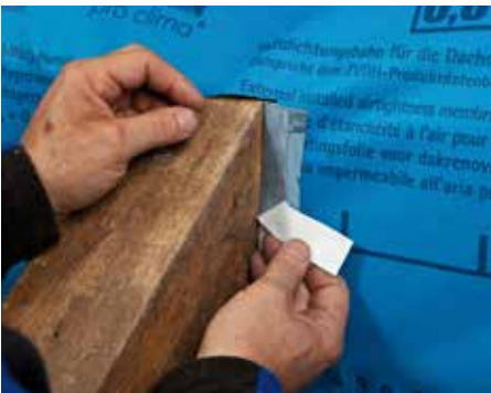
Nuimkite apsauginę plėvelę: hermetiškai suklijuokite membraną ir gegnes.
