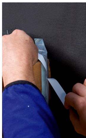
Vorgefaltetes Winkelanschlussband TESCON PROTECT auf der Trennfolie in die Ecke schieben und ersten Schenkel verkleben. Anschließend Trennfolie entfernen und zweiten Schenkel verkleben.
