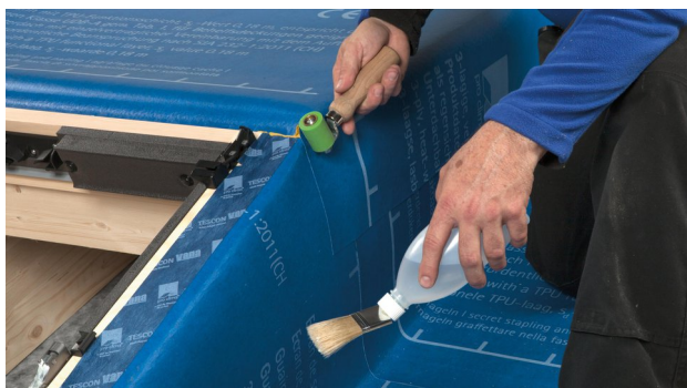
25. Savienojiet SOLITEX WELDANO 3000 slāņus vienu ar otru sānos.
