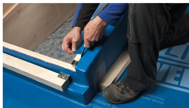
18. Izgrieziet izmēru paralēli loga rāmim. Var izmantot palīglenti, lai palīdzētu piestiprināt apakšējo malu bez krokām vai krokām.
