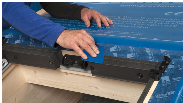
26. Izmantojiet TESCON VANA praktiskai instalācijas nostiprināšanai.
