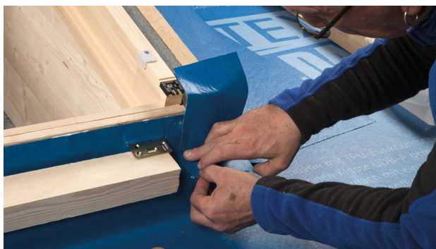
13. Pārlicinieties, ka montāžas detaļa labi iekļaujas stūros.
