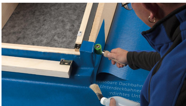
15. Pārpalikušos gabalus salociet un piemetiniet (pielīmējiet) pie apakšējās membrānas. Īpašu uzmanību pievēršiet tam, lai stūri būtu cieši noslēgti.
