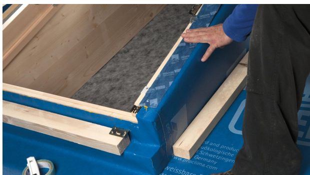
23. Izmantojiet TESCON VANA praktiskai instalācijas nostiprināšanai.
