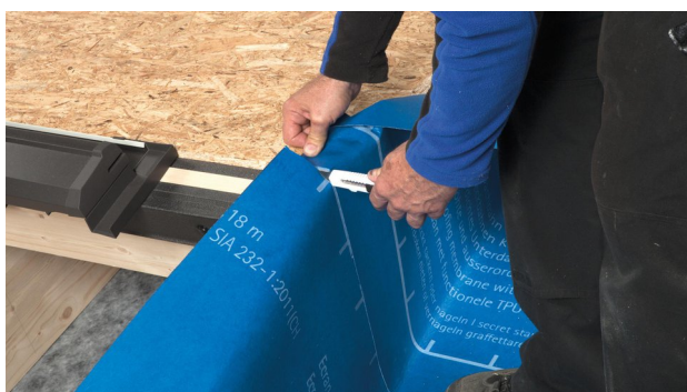
17. Novietojiet membrānu no galvenās virsmas uz ķīļveida rāmja sāniem. Alternatīvi nogrieziet jaunu SOLITEX WELDANO 3000 sloksni, novietojiet to gar ķīļveida rāmi un piestipriniet to apakšā pie plakanās membrānas.
