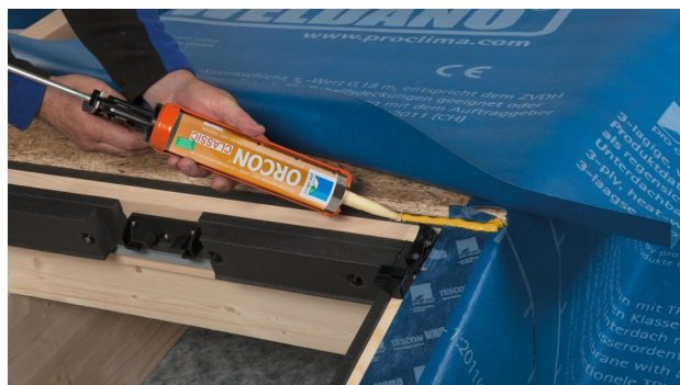
24. Piestipriniet SOLITEX WELDANO 3000 galveno loksni pie loga rāmja augšdaļas, izmantojot ORCON CLASSIC.
